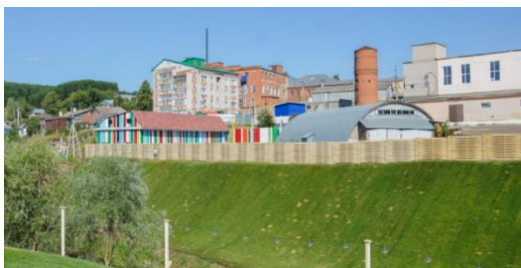
Рис.6. Обустроенная территория до пешеходного моста
